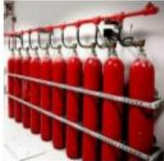
Sistemi automatici antincendio, installati in spazi chiusi, che utilizzano vari tipi di gas chimici o inerti o CO2 per lo spegnimento in casi per i quali l'acqua non può essere utilizzata (ad esempio per la presenza di energia elettrica).
